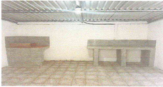
Foto1: Mejoramiento de la cocina de la escuela. Elaboración de hornilla, mesa fundida y sustitución del piso.
