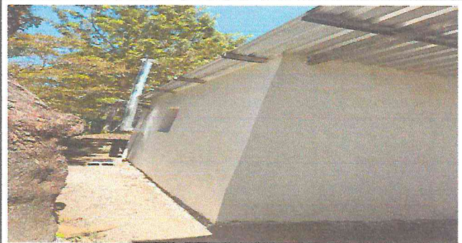
Foto 2: Colocación de chimenea por lado fuera de la cocina
