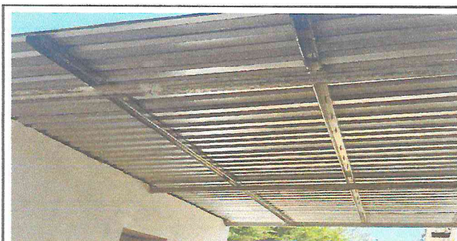
Foto 3: Estructura metálica y lámina troquelada en el corredor de la cocina
