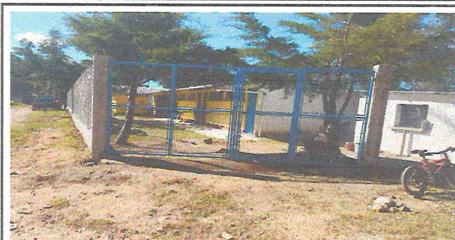
Foto 2: Colocación del portón en la entrada a la escuela
