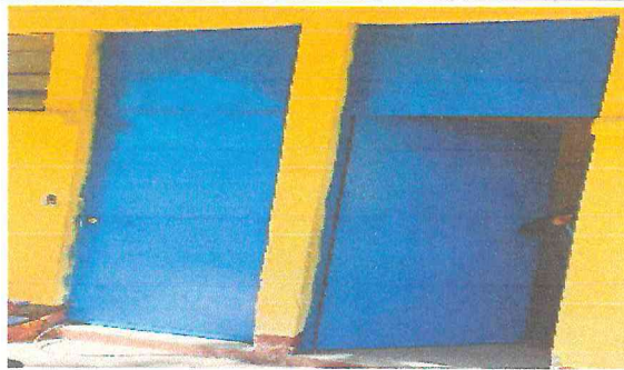
Foto 5: Sustitución de puertas
